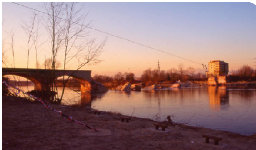
Ciò che rimaneva del ponte sul Po dopo l'alluvione del 1994
