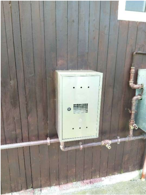
Contatore metato per bollitori su parete esterna casetta .21
