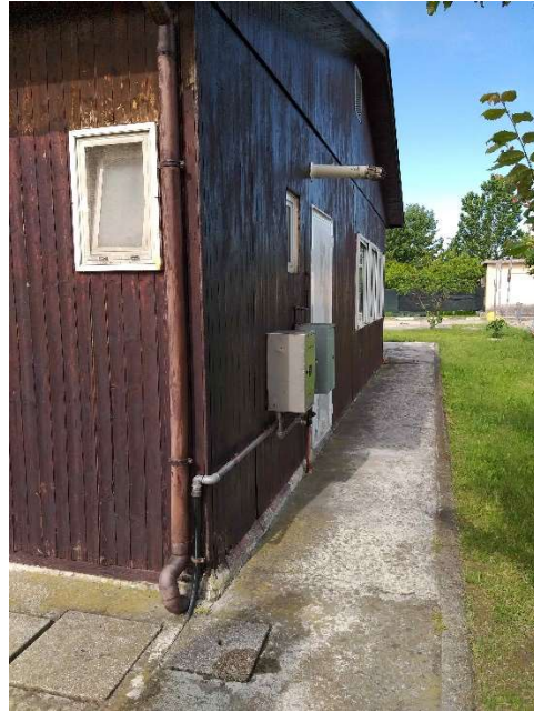
Contatore metato per bollitori su parete esterna casetta .21
