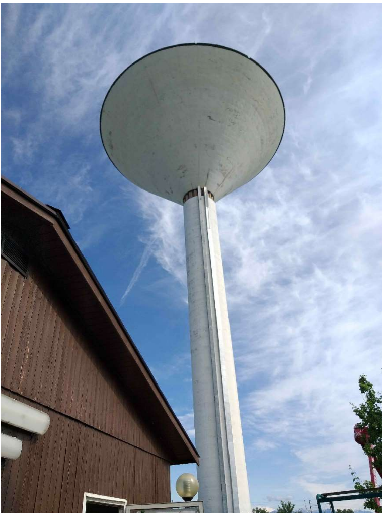
Torre piezometrica SMAT
